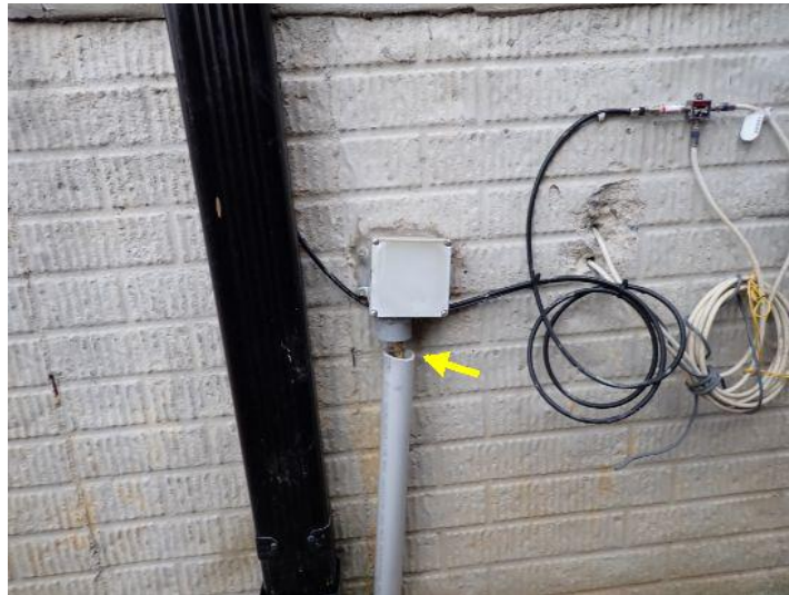
Damaged conduit
